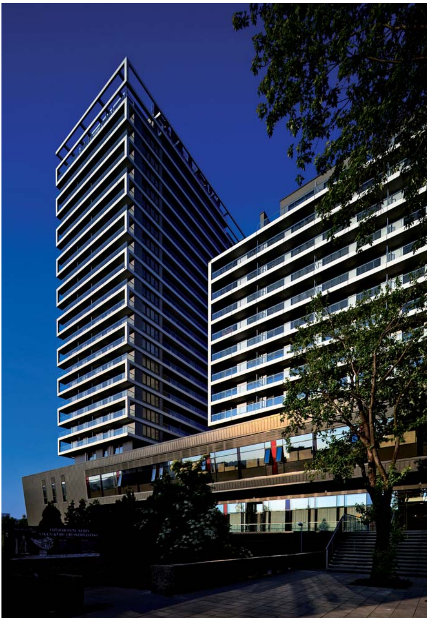
Polyfunkčný objekt RETRO – Cena Združenia pre rozvoj slovenskej architektúry a stavebníctva – ABF Slovakia. Foto: Paťo Saľko
